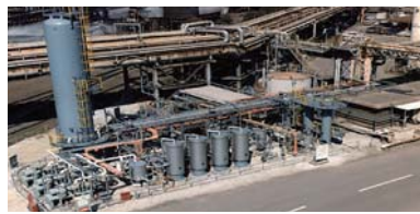
加古川製鉄所CO-PSA商業プラント 製品CO流量150Nm 3 /hr
