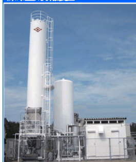
1000m 3 /hの深冷空気分離装置
